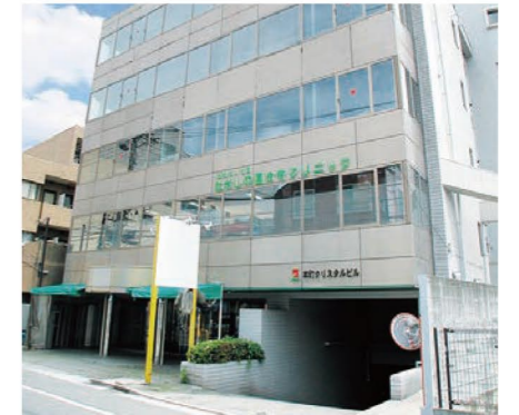
国分寺本町クリスタルビル 東京都国分寺市本町
