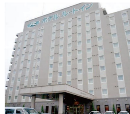
ホテルルートイン仙台長町 インター 宮城県仙台市太白区東郡山
