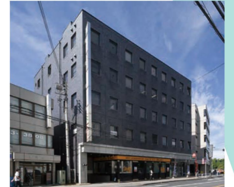
五光曙第二ビル 東京都立川市曙町
