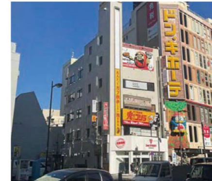
五光曙第一ビル 東京都立川市曙町
